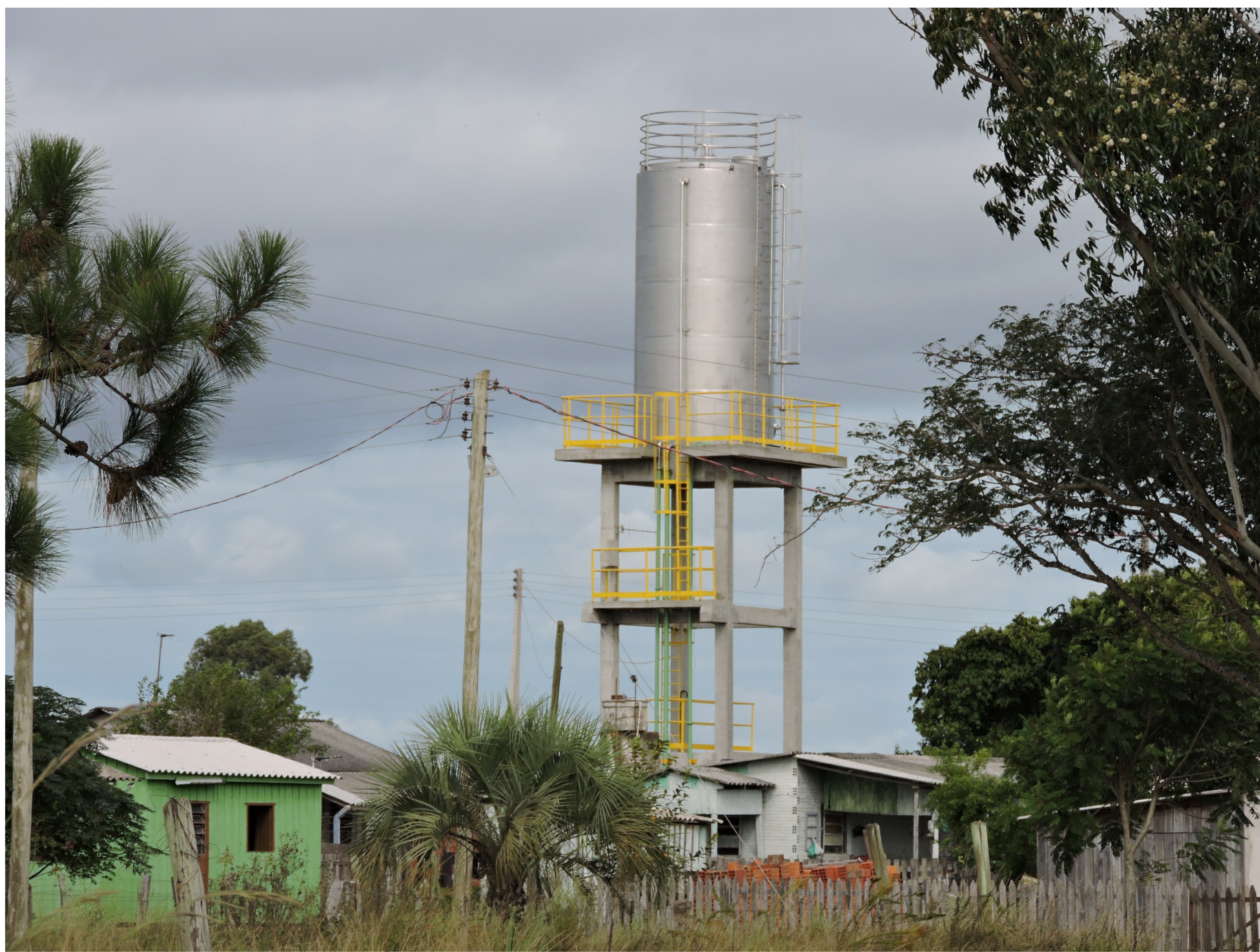
Reservatório com capacidade para 50 mil litros foi instalado na vila. Fotos: Cacau Moraes
