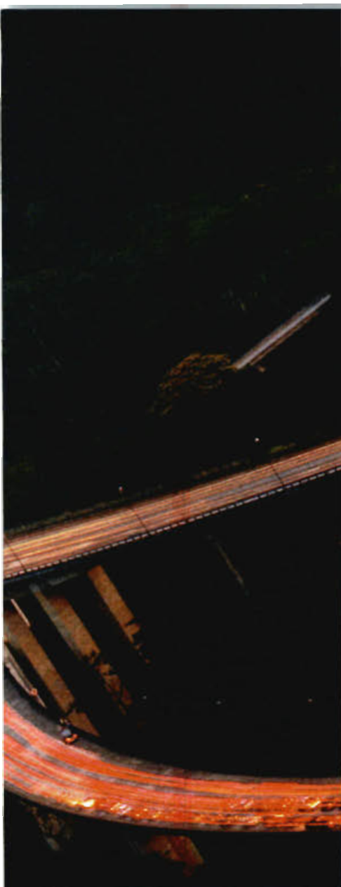
PISTA LIVRE Viadutos na Rodovia dos Imigrantes, em São Paulo: modelo para a privatização federal
