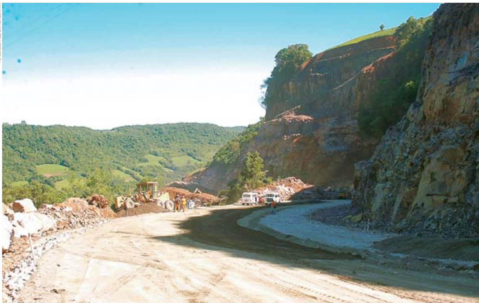
ÚLTIMO trecho em construção: equipes trabalham na colocação da base com pedras brutas em uma extensão com aproximadamente um quilômetro na Serra
